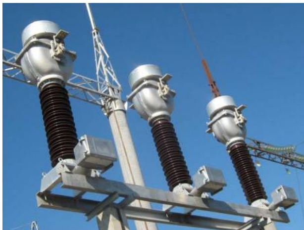
Рис. 4. Трансформаторы тока
