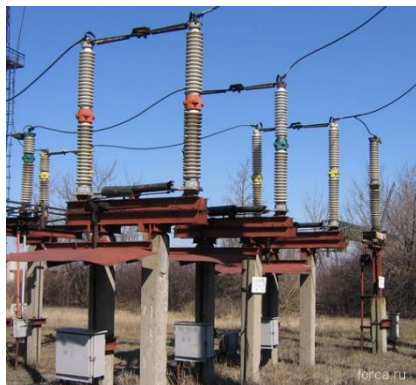
Рис. 1. Отделитель и короткозамыкатель
